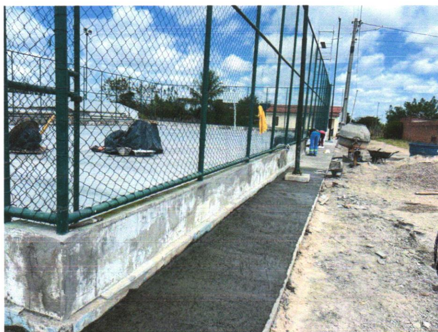
Foto 10 - ALAMBRADO PARA QUADRA POLIESPORTIVA, ESTRUTURADO POR TUBOS DE AÇO GALVANIZADO, (MONTANTES COM DIÂMETRO 2", TRAVESSAS E ESCORAS COM DIÂMETRO 1 ¼ ), COM TELA DE ARAME GALVANIZADO, FIO 10 BWG E MALHA QUADRADA 5X5CM (EXCETO MURETA). AF_03/2021
