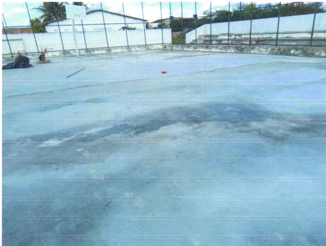
Foto 07 - PISO EM CONCRETO 20 MPA PREPARO MECÂNICO, ESPESSURA 7CM. AF_09/2020
