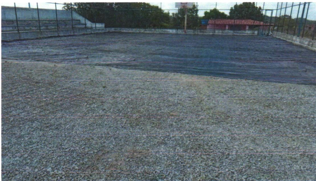
Foto 03- LASTRO DE BRITA GRADUADA APLIADA E=10CM
